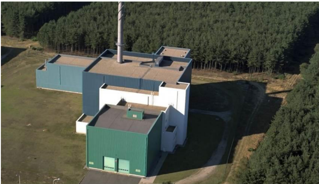
Figure 14 : Bâtiment 136 qui assure l'entreposage des déchets issus du retraitement du combustible usé
